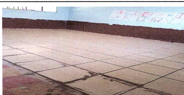
Foto 5: Cuando ya se esta terminando la colocacion de pisos en todas las aulas
