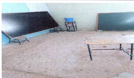
Foto 1 : mejoramiento de piso
