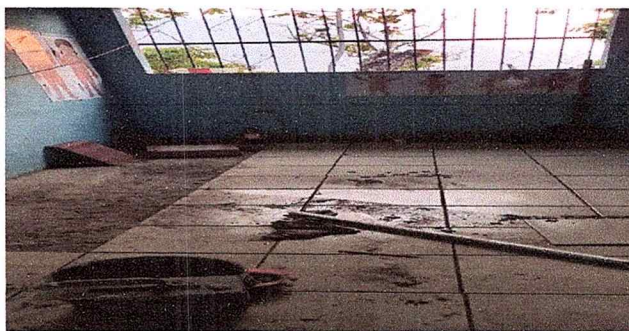
Foto 4: colocacion de piso en el aula de preprimaria.
