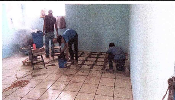
Foto 3: Cuando estan colocando el piso en cada aula.
